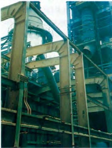
Kömür Değirmeni Ünitesi ve Ön - Isıtıcı Kulesi Montaj Çalışmaları.
