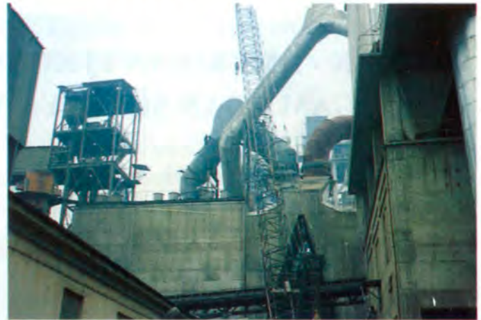
I. Döner Fırın Elektrofiltre Emiş Borusu Değişimi Montaj İşleri.
