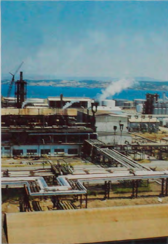
Off-Site Boru İnşaat, İmalat ve Montaj İşleri (1986)
